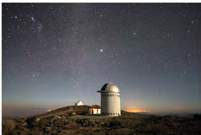
Obserwatorium Las Campanas w Chile. Budynek, w którym mieści się teleskop warszawski projektu OGLE. Fot. E. Zegler-Poleska
